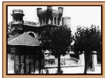
Edificio denominado "El Castillo" de la familia Pavlisa, en la calle Arturo Prat, demolido sorpresivamente mientras se efectuaban trámites para conservarlo.
