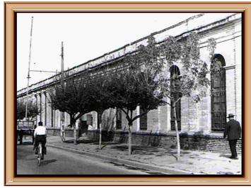
Antigua Escuela de Suboficiales frente a la Plaza de Armas, donde hoy está el edificio municipal.
