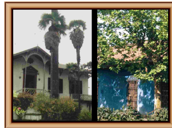
Casa-quinta de la familia Dagnino en la calle Covadonga muy dañada en el terremoto del año 2010 y la Casa Azul de la calle Urmeneta, propiedad de Claudio Matte y de la familia Saldes también demolida.
