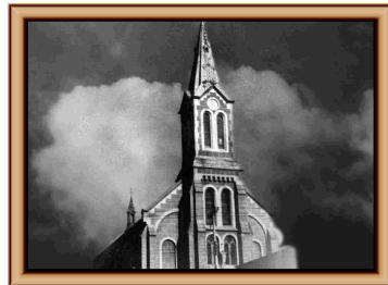
Iglesia de San Clemente y Seminario de los Padres Redentoristas, demolida después del terremoto del año 1985.
